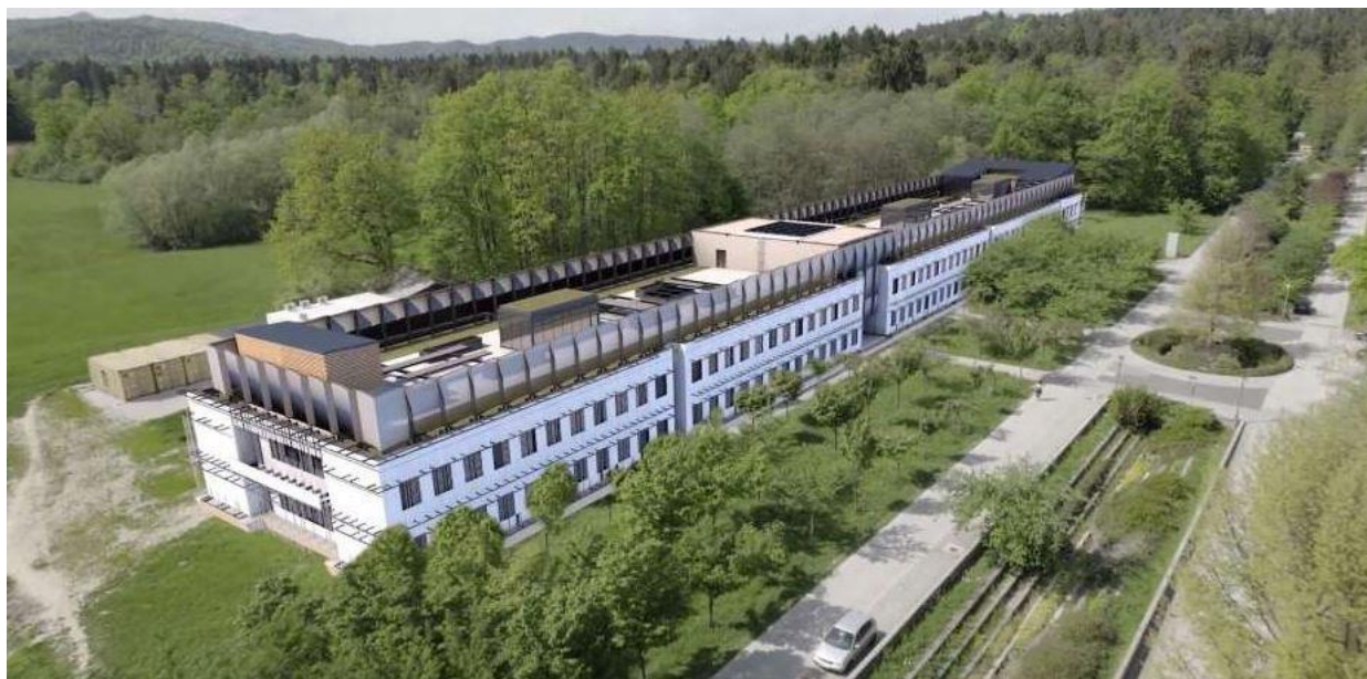
Gradnja Biotehniškega stičišča Nacionalnega inštituta za biologijo
