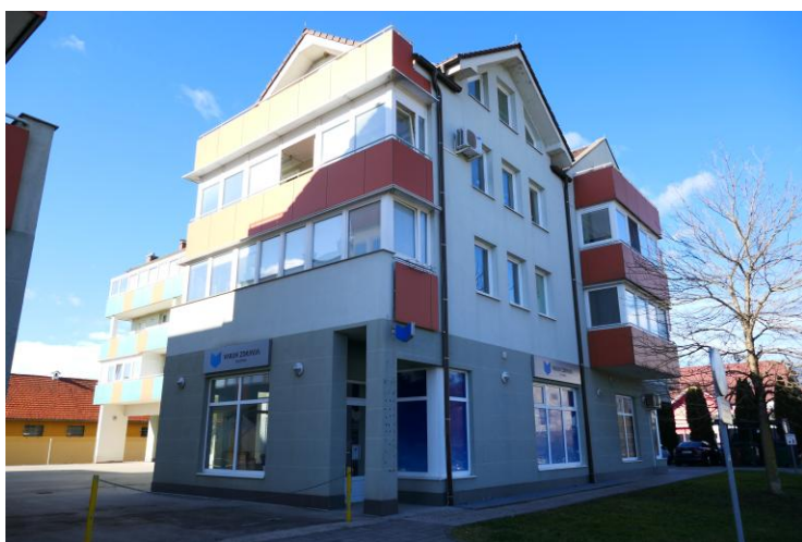
Slika 14: Stavba ob Čopovi ulici (vir: A. Polšak)
