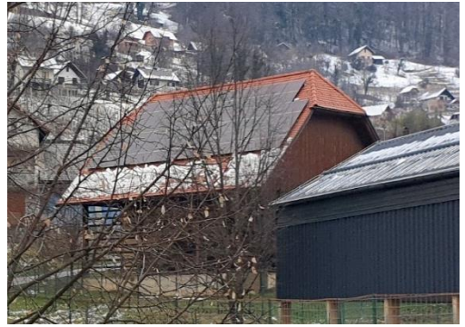
Slika 10: Hiša s fotovoltaičnimi celicami Vir. A. Polšak. 2025.
