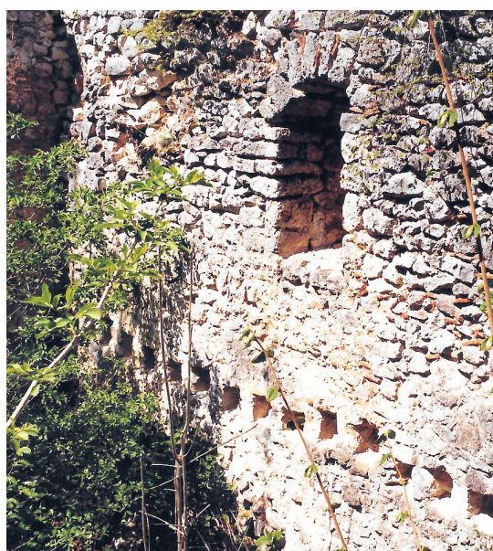
Slika 15: Detajl severne stene palacija z odprtini za tramove nad kletno etažo
