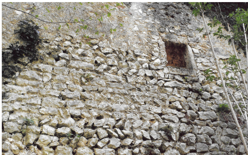
Slika 13: Značilna zidava na opus spicatum (ribja kost ali žitni klas) v severni steni palacija
