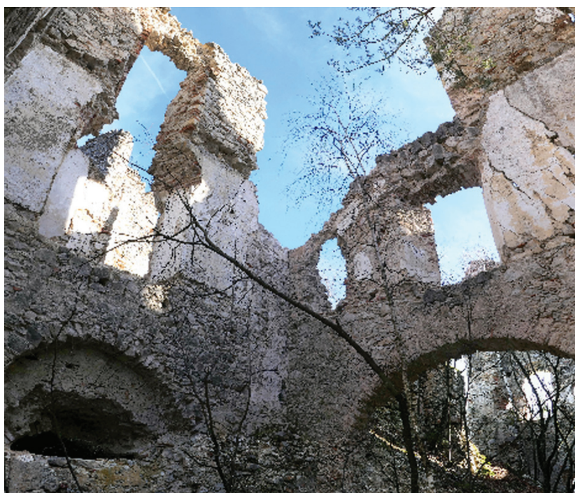
Slika 16: Razvaljena notranjost renesančnega dela gradu
