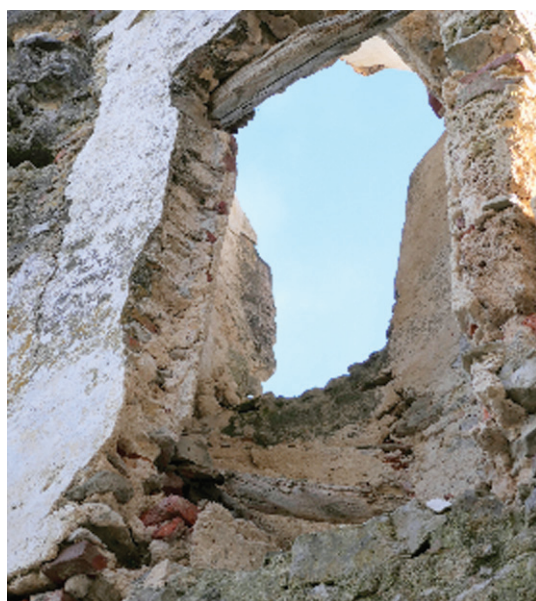
Slika 9: Stopnice v zidu kot prehod iz tretje etaže v podstrešje gradu
