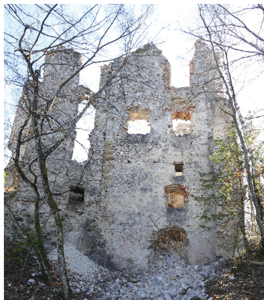
Slika 14: Severna stena gradu
