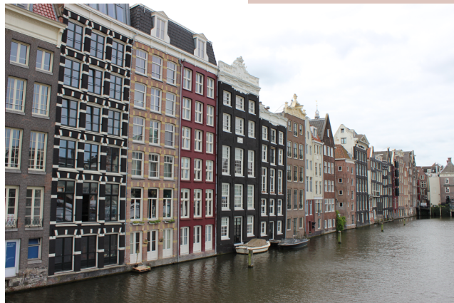
Stavbe v Amsterdamu. (Foto: Bojana Modrijančič Reščič.)
