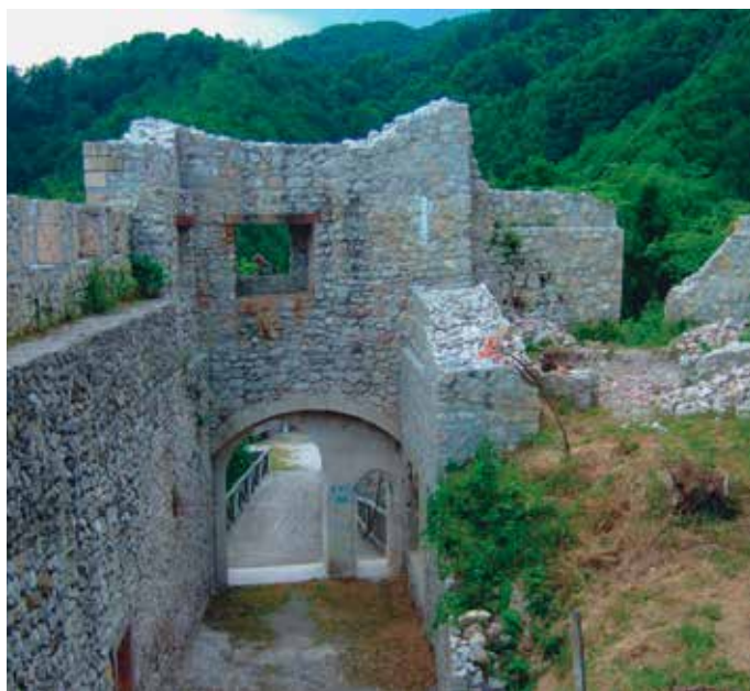
Slika 11: Pogled na delno obnovljen vhodni stolp z južnega medzidja junija 2008 Foto: A. Polšak
