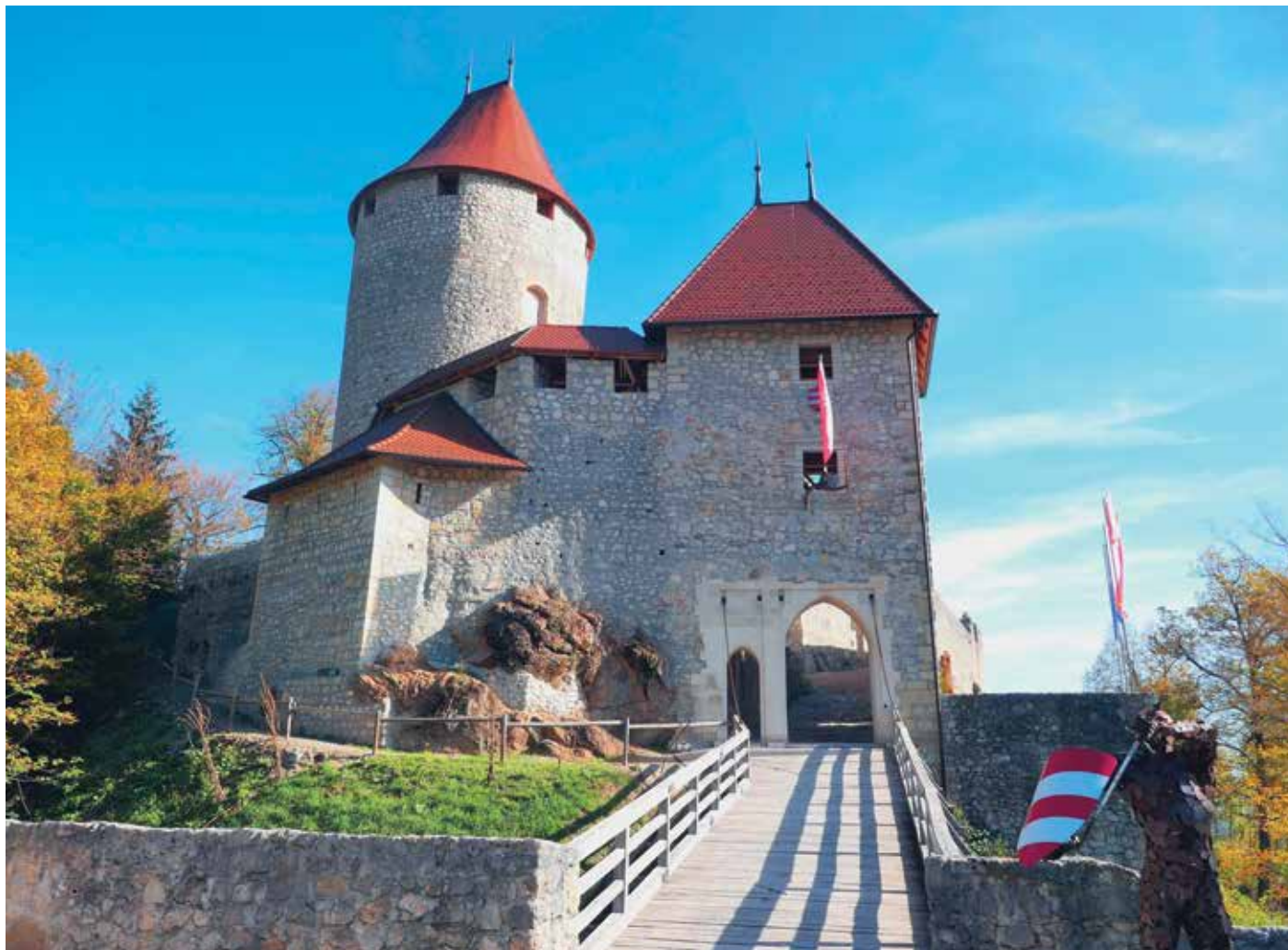
Slika 13: Pogled na že drugič prenovljen most preko nekdanjega zadnjega obrambnega jarka in obnovljen vhodni stolp z zahoda. Most je jasno narisana tudi na franciscejskem katastru iz leta 1825.
