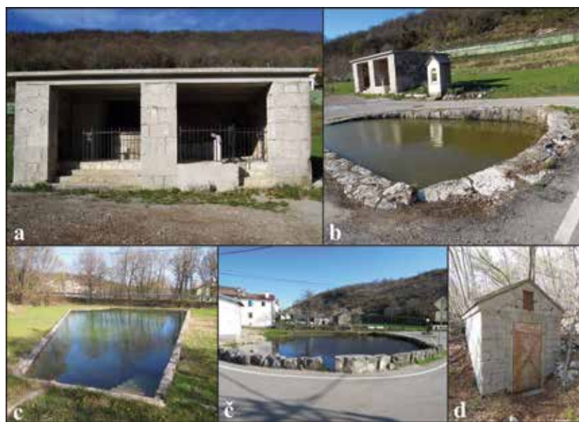
Slika 2: Vodni viri (objekti) na območju Rakitovca (a – vodnjak Skedenc, b – kal Skedenc, c – kal Pod Veli hrib, č – kal Na lokvi, d – rezervoar za oskrbo železnice)
