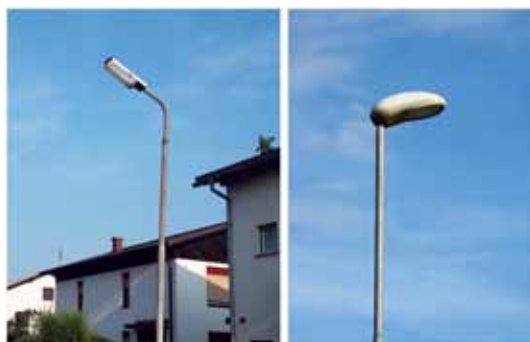
Slika 4: Primeri nepravilno nameščenih svetilk javne ulične razsvetljave v Sloveniji. Foto: Bezgovšek, 2019
