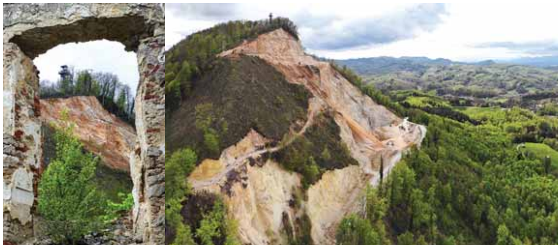
Sliki 3 in 4: Kamnolom Žusem, kakor ga zajamemo s fotoaparatom z razvalin in z dronom z istega mesta (pogled na kamnolom z vzhoda). Čeprav je možno kamnolom videti tako z zgornjega roba kot s ceste, pravi obseg dojamemo šele s slike, narejene s pomočjo drona (desna slika).
