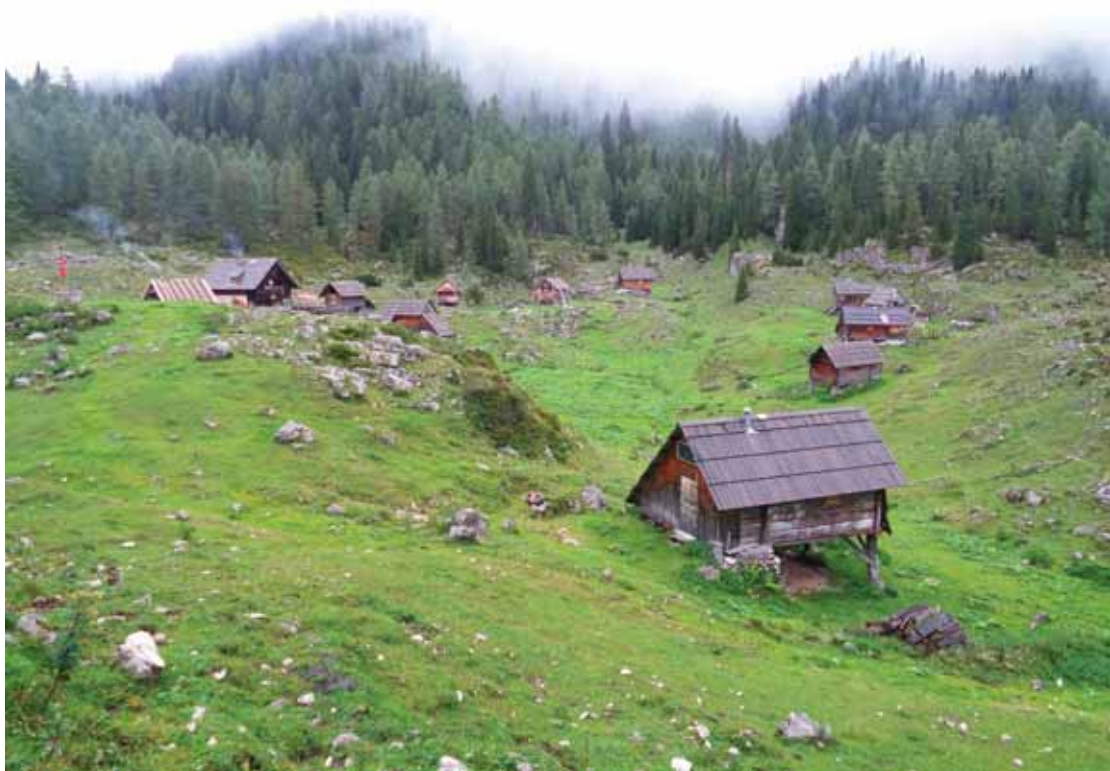
Slika 3: Planina Dedno polje (1560 m), primer tradicionalne gradnje na neravnem terenu (kamnit podstavek in lesene »kobile« oz. podporniki), ki kaže na dobro poznavanje naravnih danosti in izkušnje graditeljev, ki so se prenašale skozi generacije.
