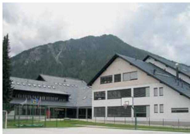
Slika 2: Osnovna šola Josipa Vandota Kranjska Gora
