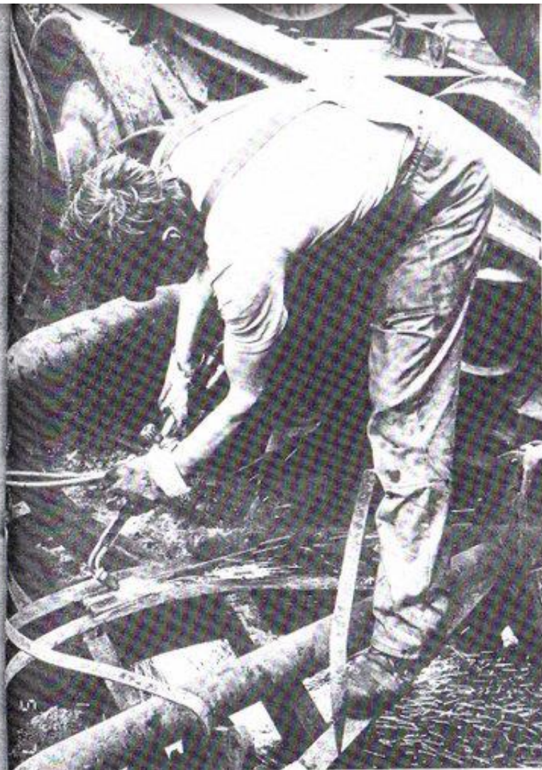
...mo pa z varilnim aparatom razrezali še podstavek ter tako z mostu čez Belo odstranili zagotovo eno naj- bolj in najmočnejših cestnih zapor na Ptujskem.
