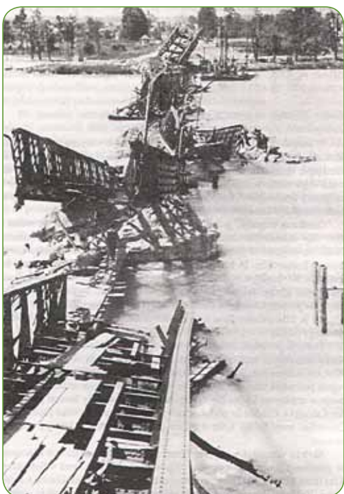
Porušeni most na Ptuj
