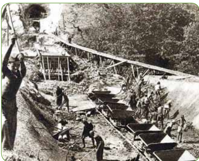
A haza újjáépítése
